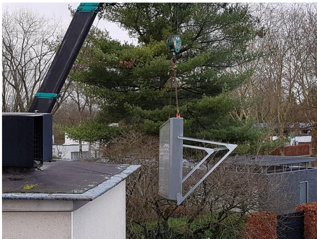
Figuur 3-2 Stap 4: plaatsen van de SOWISE zonneboiler.
