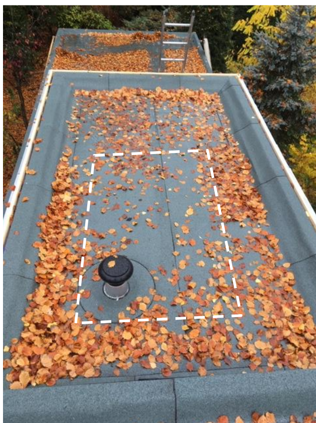
Figuur 3.1 Stap 1: plaatsbepaling en vrijmaken dakvlak.
