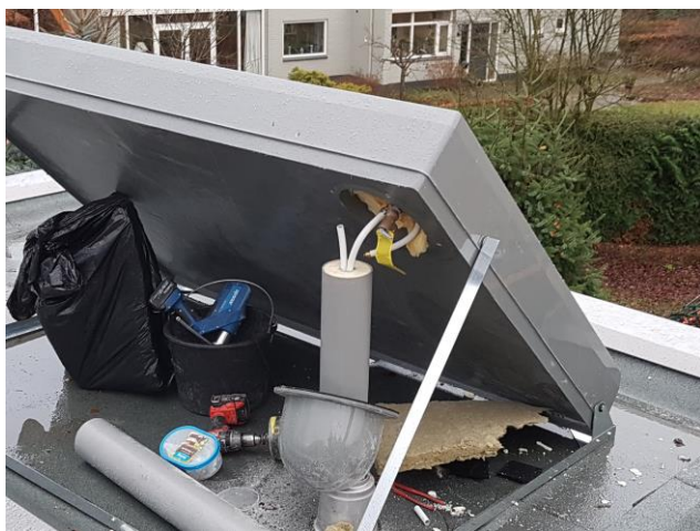
Figuur 3-3 Stap 6: Geïsoleerde mantelbuis op maat maken.
