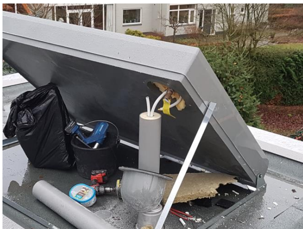
Figuur 3-5 Stap 10: Aansluitkap vastzetten.
